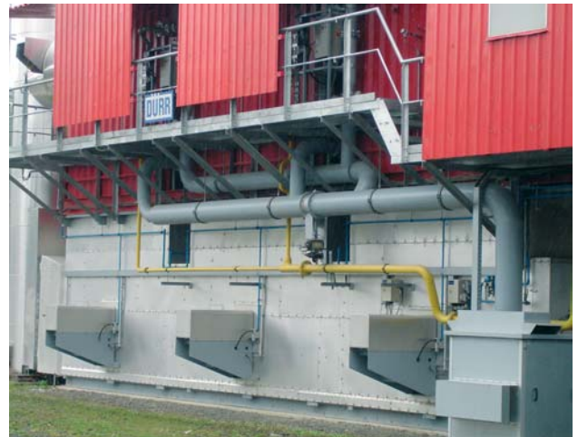
RTO-Abluftreinigungsanlage.
